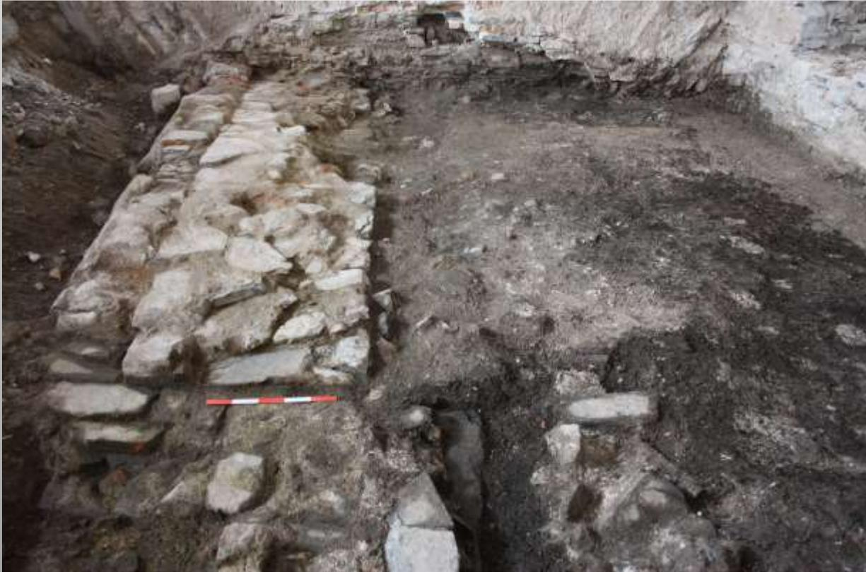
La muratura è realizzata in blocchi squadri di Moltrasio, di forma non regolare, con qualche frammento di laterizio, legati da malta bianca, tenace.
