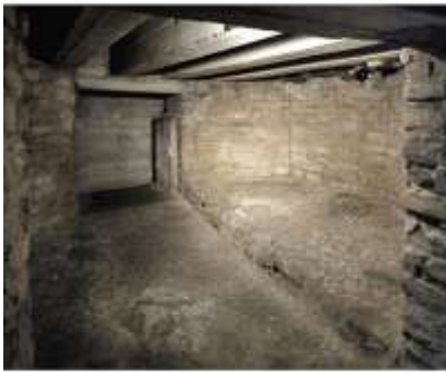
resti della torre ovest
